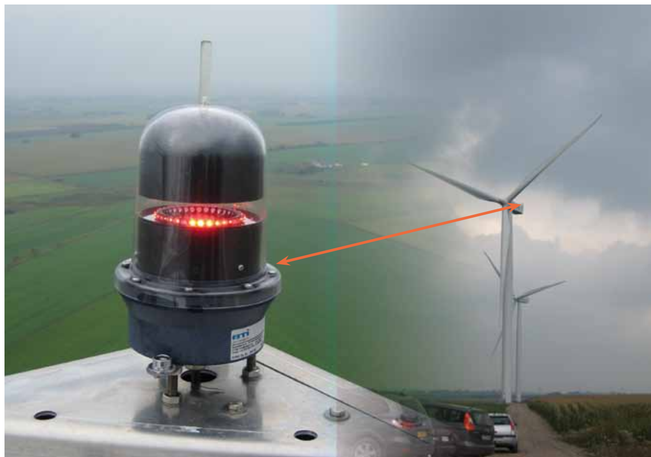
Foto 5.27 Lysafmærkning for flysikkerhed.
