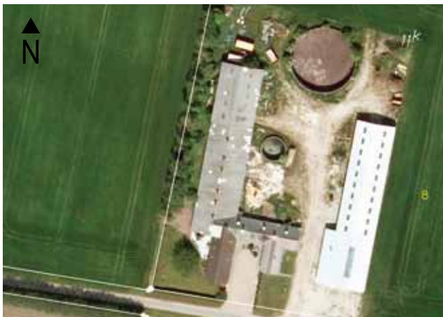
Luftfoto 5.8 Nabobolig 8, Egebjergvej 10.
