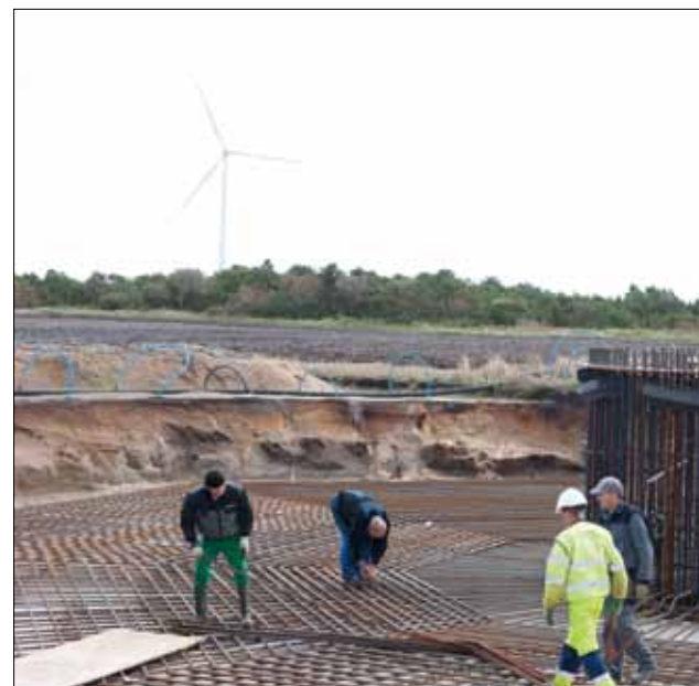
Foto 3.3 Binding af fundament.
