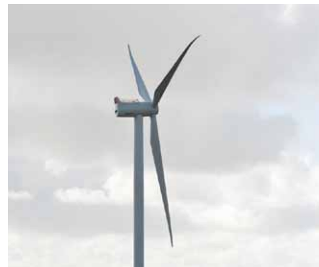
Foto 3.2 Møllehus på en gearløs Siemens vindmølle med 113 meter rotor. Tårnet er placeret midt på møllehuset. Det ses her tydeligt, at vingerne bøjer i spidserne, og toppen ikke er i water, men sænket bagud.
