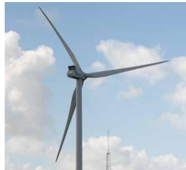
Foto 3.1. Møllehus på en Vestas med 112 meter rotor og gear. Tårnet er traditionelt placeret forrest på møllehatten.
